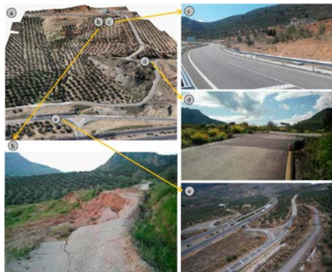
Slika 2. Klizište i zahvaćeni putevi: (a) Opšti izgled klizišta; (b) Glava klizišta i put JA-3200 prekinut; (c) Put JA-3200
