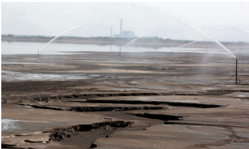
Pepelište oko TE Nikola Tesla u Obrenovcu
