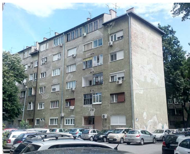
Slika 1. Izgled stambenog objekta sa severozapada.
