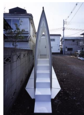
Slika 2. Bočni izgled kuće.
