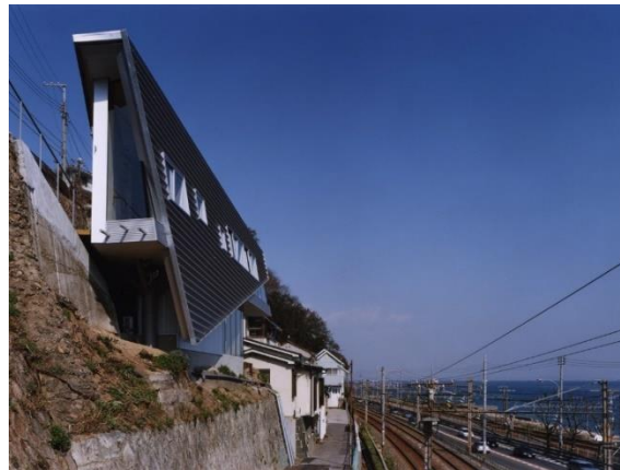
Slika 5. Bočni izgled kuće.
