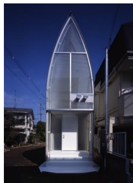
Slika 1. Bočni izgled kuće.
